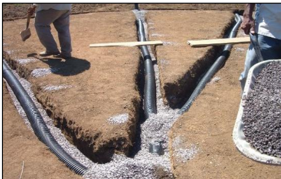
Imagen N° 60: Sistemas de drenaje superficial
